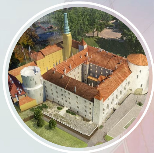
Rīgas pils konventa restaurācija un pārbūve
